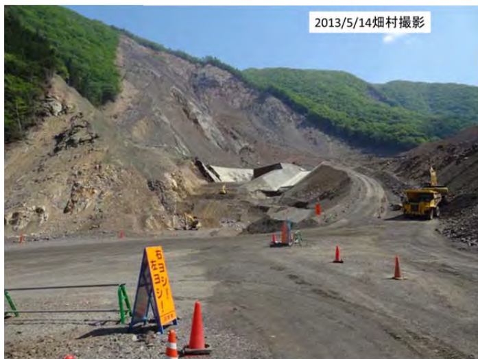
図22 五條市赤谷地区の深層崩壊現場[2]
