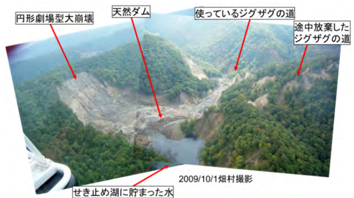
図31 空から見た岩手宮城内陸地震での湯浜(ゆばま)温泉下2kmの大崩壊と天然ダム
