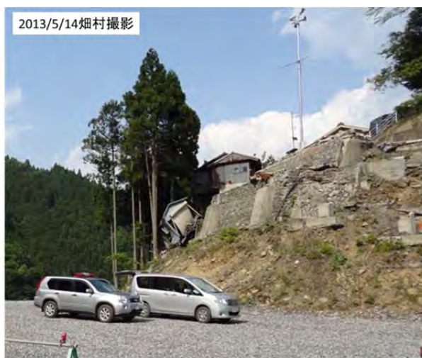
図26 五条市清水地区の斜面崩壊現場[3]
