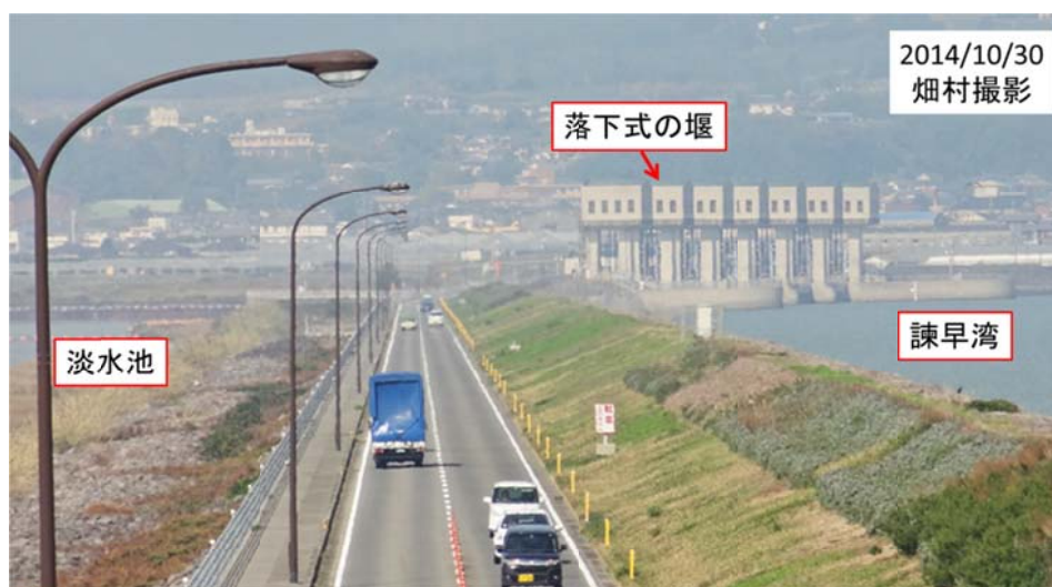
図27 諫早湾干拓潮受堤防(全長7km)を横断歩道橋上から望む
