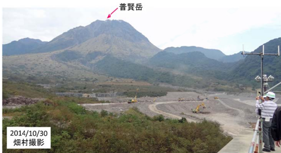
図15 無人化施工による砂防ダム建設現場 カメラ車・ショベル・ダンプなどすべて無線遠隔操縦されている。
