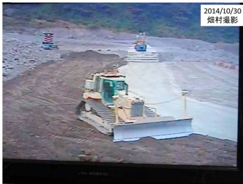
図19 オペレーションルームでは土砂を型枠にを使った コンクリート製堰堤の構築の動画が表示されていた。
