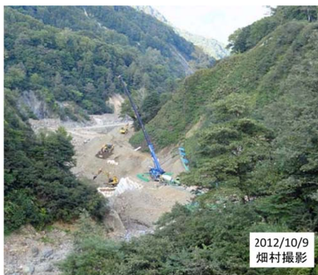
図10 金山沢(浦川の支川)にかかる金谷橋の下流にある無人化施工現場(稗田山崩れは右後方)
