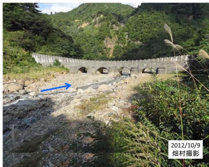
図9 浦川(姫川の支流)スーパー暗渠砂防堰堤
