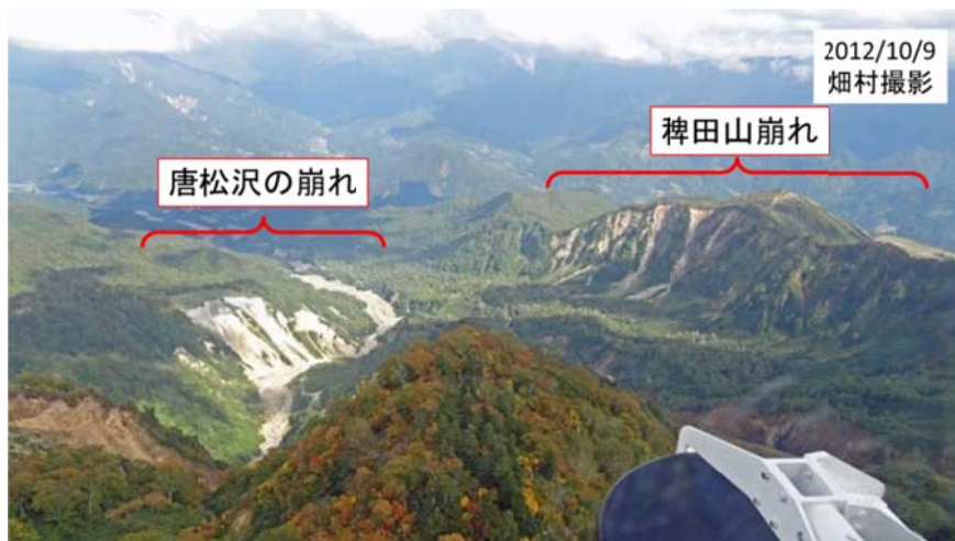
図3 稗田山崩れを上流側から見る（ヘリから撮影）
