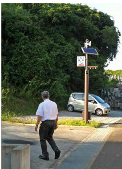
図17 避難場所付近にあった様々な工夫をした案内装置
