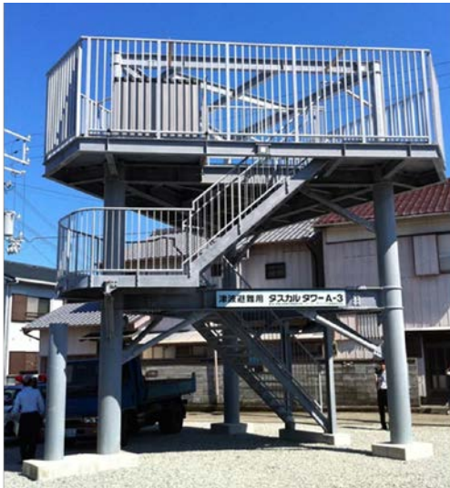
図9 串本町堀笠島地区の津波避難タワー (避難ステージ高さ5.6m, 海拔約10m)
