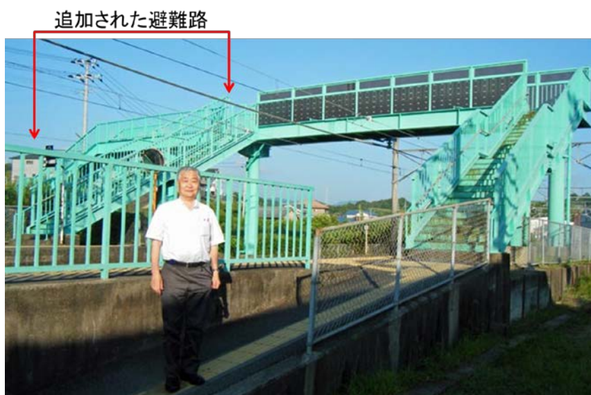
図14 紀伊新庄駅で跨線橋(右)に追加された避難路と筆者
