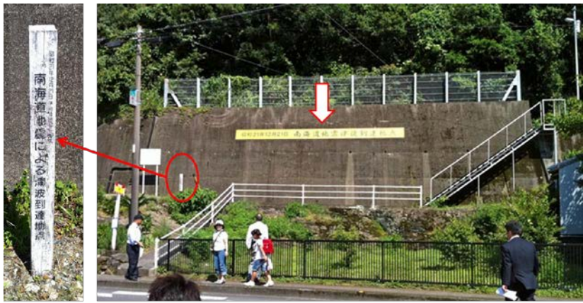
図8 津波到達高さ7.9mを示す帯と到達地点標(串本市袋地区)
