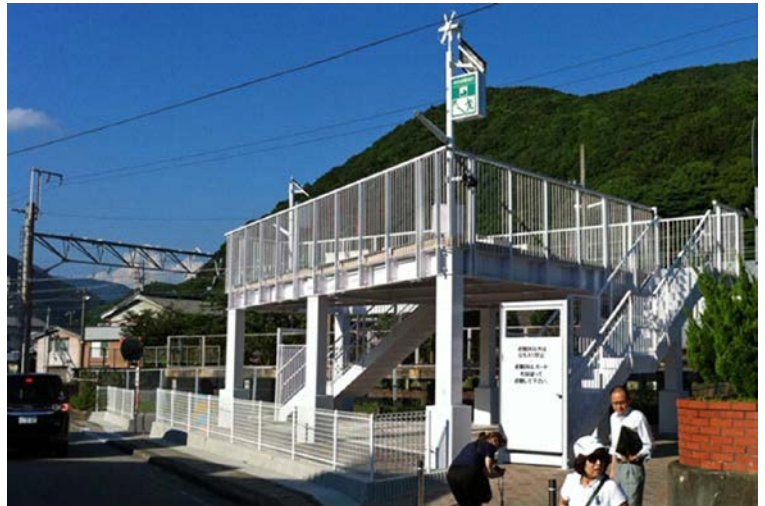
図10 紀勢線周参見(すさみ)駅脇にある津波避難タワー (避難ステージ高さおよそ3.5m, 海拔約4.8m)
