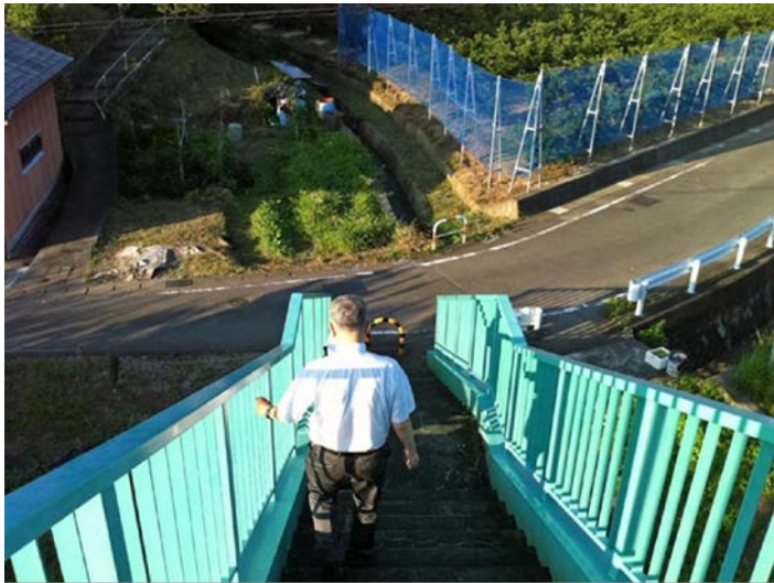
図15 避難路から一般道に降りた所に誘導標識がない
