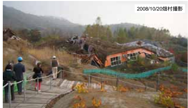
写真11 噴火でつぶされたお菓子の工場
