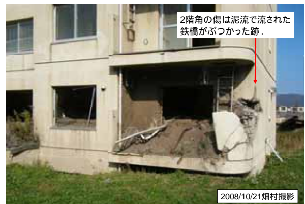
写真28 熱泥流がたまったままのアパート2階 右端の傷は鉄橋がぶつかった跡.
