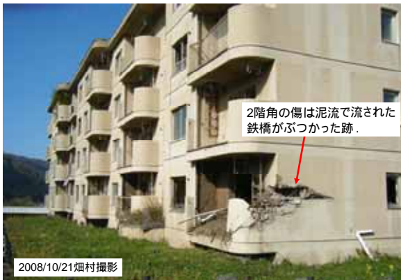
写真27 噴火遺構公園内に残されたアパート 噴石と熱泥流で使用不能に. 他のアパートは撤去された.
