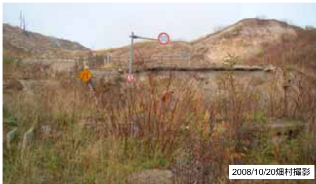
写真12 旧230号線の道路標識
