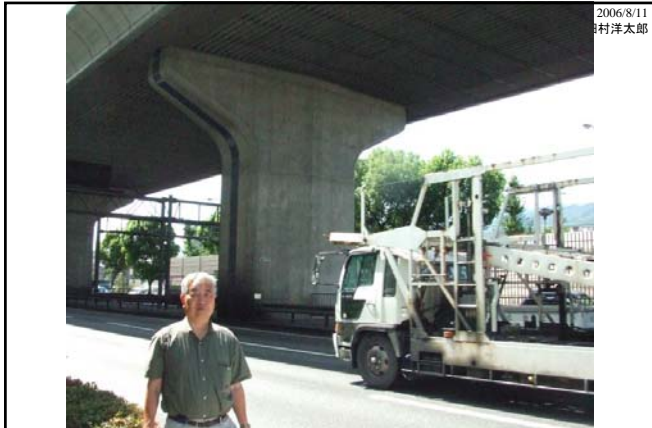
写真 イチョウの形の太い橋脚で建て直された阪神高速道路 (2006/8/23畑村撮影)
