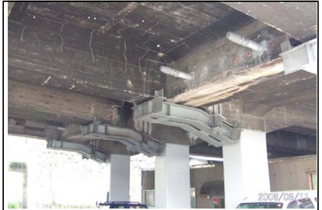
写真1 由比漁港脇の国道1号線の橋脚の補強 [2006/8/11畑村撮影]
