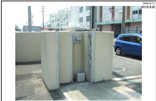
写真11 津波防護用可動扉の受けの部分 [2006/8/11畑村撮影] (生存空間の考えがないので人が挟まる可能性がある)
