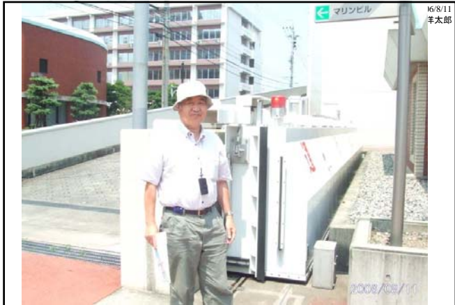
写真9 津波防護のための遠隔操作扉 [2006/8/11撮影]
