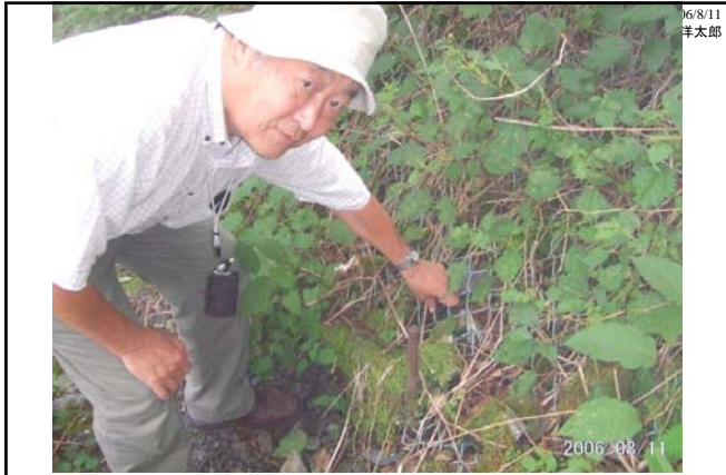
写真24 大谷崩の山腹工。 植物を根付かせるため小石の表面に金網が張り付けてある
