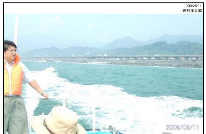
写真5 テトラポットによる海岸侵食防護 [2006/8/11畑村撮影]
