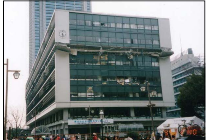
写真26 6階部分が潰れた神戸市役所2号館(1995-2-9畑村撮影)
