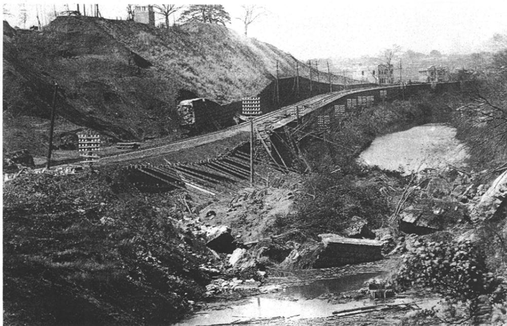
御茶ノ水駅附近／土砂及線路土留石垣崩壊外濠埋没ノ惨状 (線路ハ土砂崩壊ト同時ニ外濠内ニ決壊)
