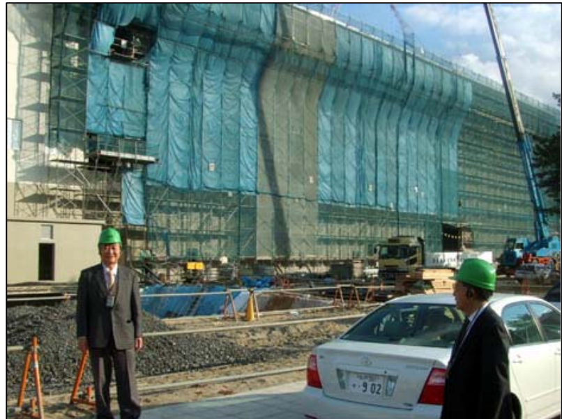
写真1 物質生命科学研究施設の建設現場にて（2005/12/8）
