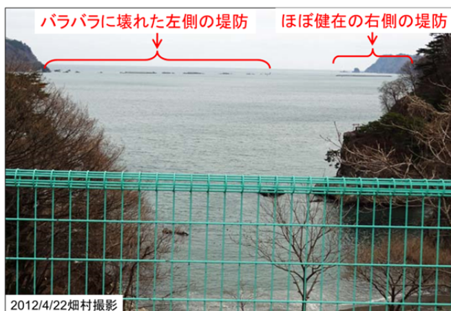
20年の歳月と1200億円をかけて作った世界最大の水中堤防も今回の津波であっけなく壊れた。
