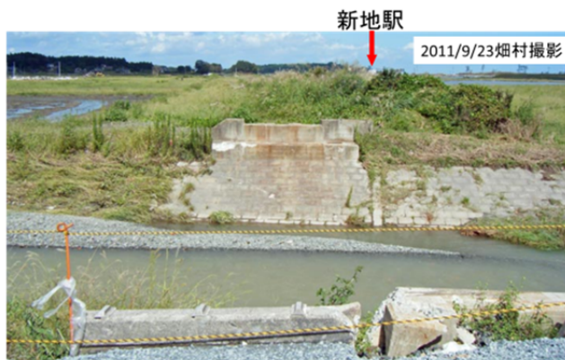
図35 橋梁が流されたJR常磐線の鉄橋跡 (手前の橋脚脇に踏切があり、海側から避難する車が渋滞した.)
