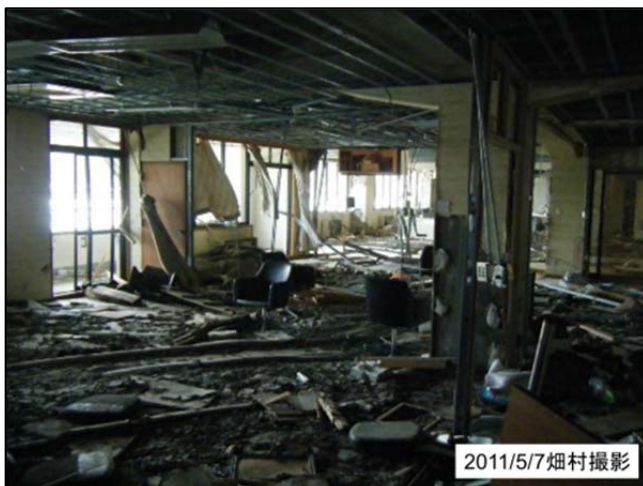
図24 津波に洗われた大槌漁協2階内部
