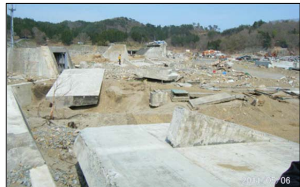
図4 木端微塵にブツ壊れた田老の新しい防潮堤
