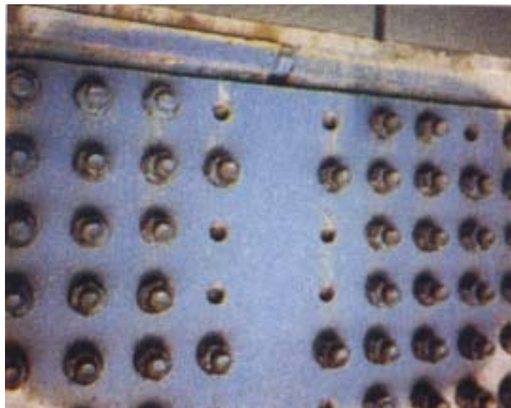
写真-2 添接板のボルト接合部分
