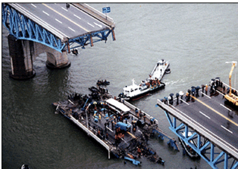
写真－1 聖水大橋の崩壊落下事故直後の状況 （写真提供：東京大学 藤野陽三教授）
