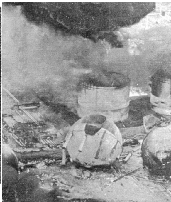
図5 被災タンクヤード概観
