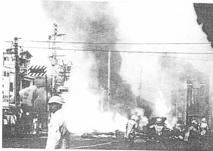
図2 ガス爆発による火災の状況
