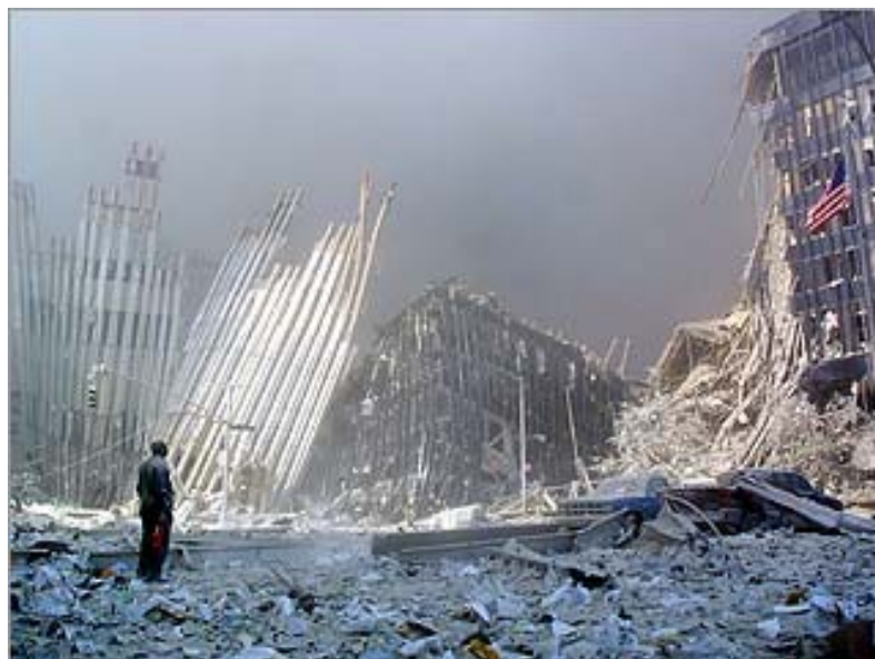
写真3 WTCビル倒壊後の状況 [1]
